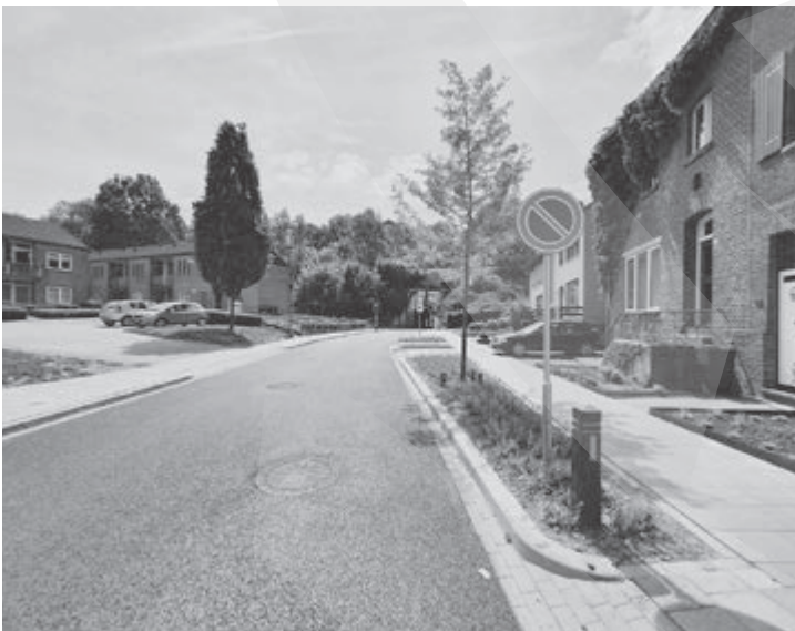
In de Herver is zowel ondergronds als bovengronds de infra klimaatbestendig vernieuwd.
