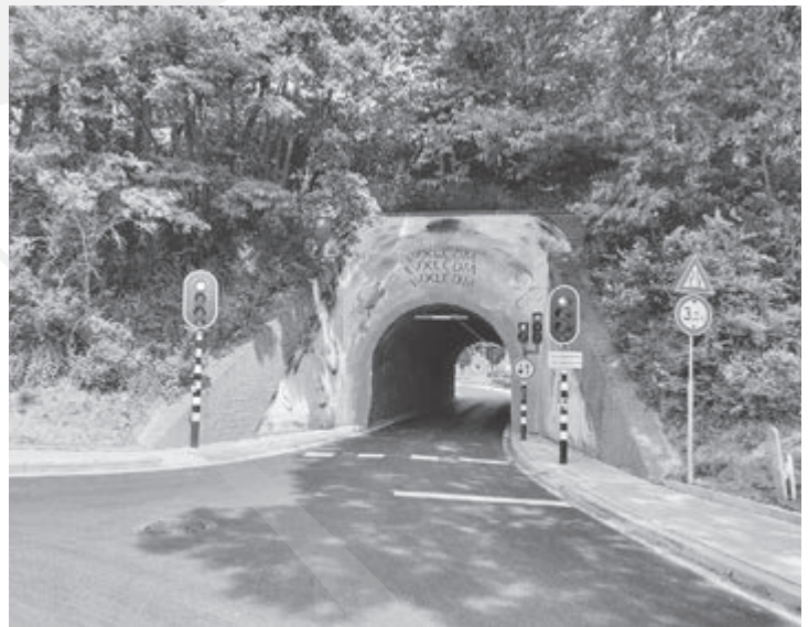
De Vlengendaal met haar bijzondere tunneltje markeert het einde van het werk.
