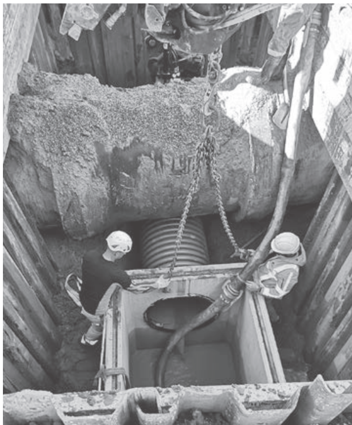
Bouwput van 4,5 m diep voor een zinker van het nieuwe regenwaterriool onder het bestaande vuilwaterriool door.
